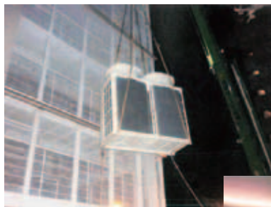
←室外機の入替の様子
