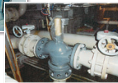
冷却水系統三方弁→ の交換
