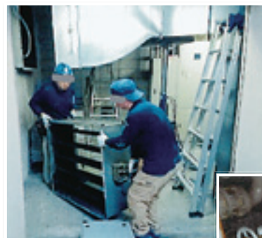
←防火ダンパーの 交換の様子
