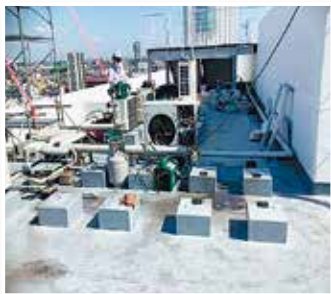
〈空冷ヒートポンプ更新工事〉
