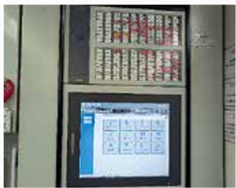
〈照明制御装置更新工事〉
